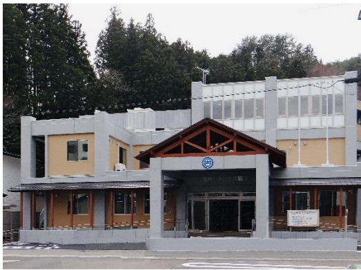
田老総合事務所庁舎
